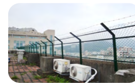
圖 ▽ 教研大樓屋頂防護網
