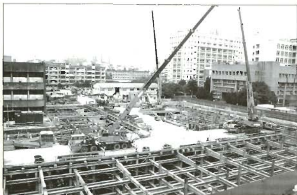
● 綜合大樓在工作人員積極趕工的情況下，土地開挖澆築已大體完成，未來建物將層層築起，完工指日可待
