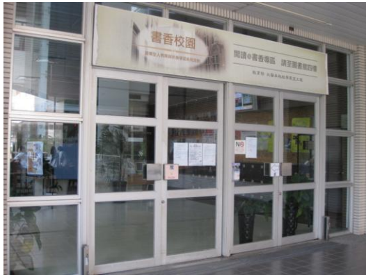
改裝前舊大門
