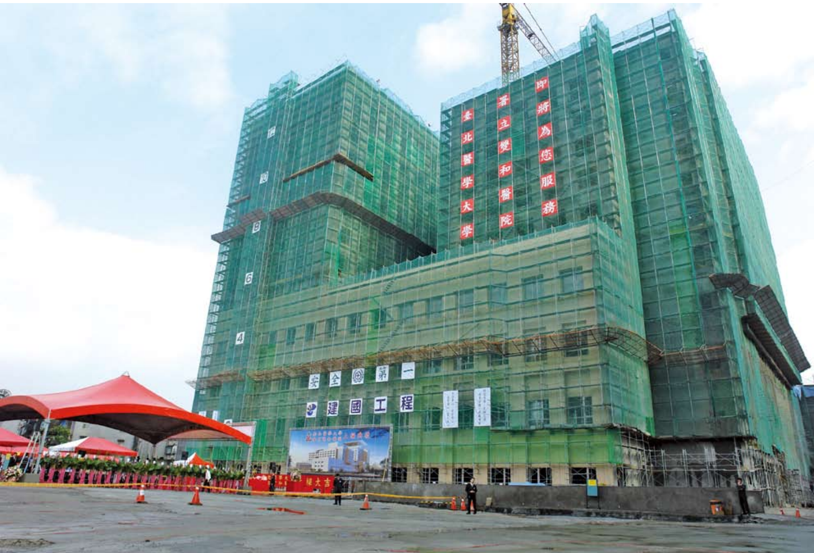
94年10月動工的雙和醫院，主體鋼樑結構接近完成
