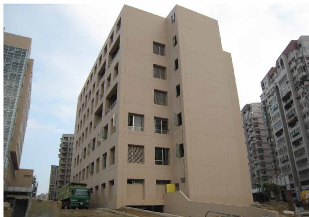
接近完工的動力中心
