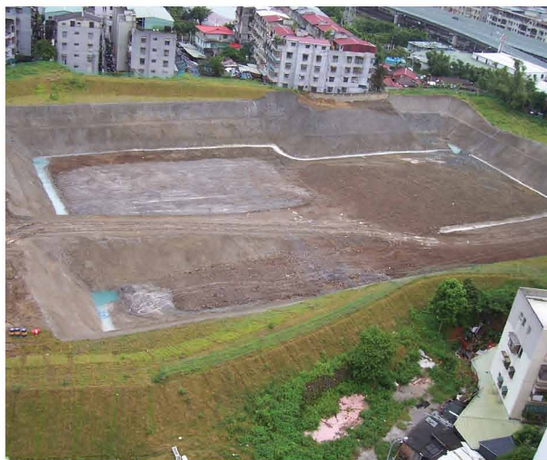
A 基地土方移除及整地工程完工狀況
