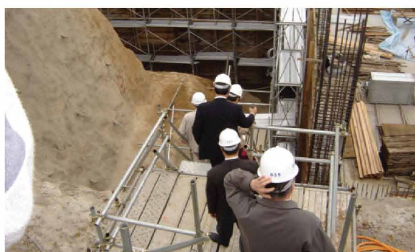
公共工程委員會至雙和查核施工狀況
